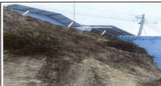
Foto 6: Reparación de muro de contención
