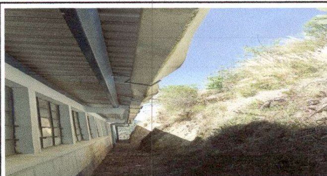
Foto 2: Sustitución de canal de PVC
