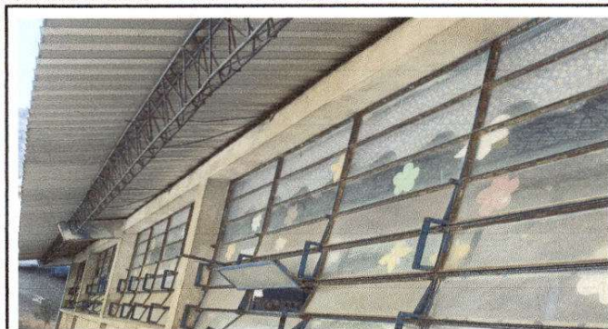
Foto 1: Sustitución de vidrios
