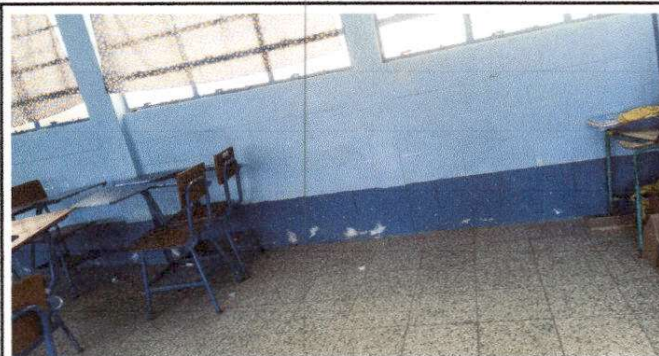
Foto 4: Pinturas de muros exteriores e interiores
